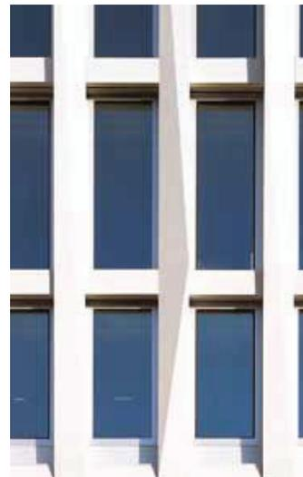
Das T-Modul umfasst die Mittelachse sowie die beiden oberen Fensterbrüstungen
