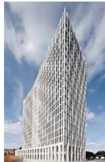
Für die Fertigteilelemente wurden 200 Guss-Formen gebaut
